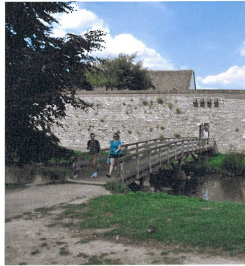
De huidige voetgangersbrug bij het Nieuwenhofpoortje
